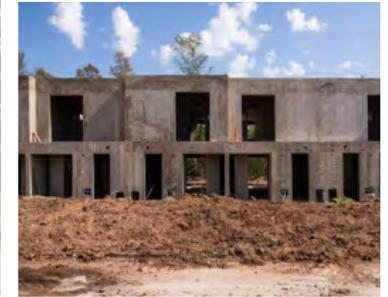
> Arriba: Oliden Joven utiliza un sistema de encofrado reutilizable de aluminio.
